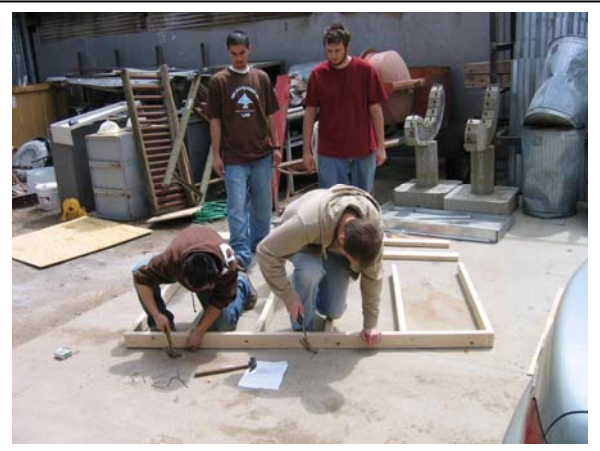
Fig. 4a: Wall Framing
